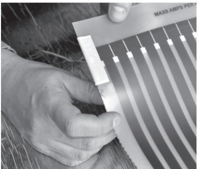
Рис. 9. Окончание процесса изолирования линии отреза медной шины
