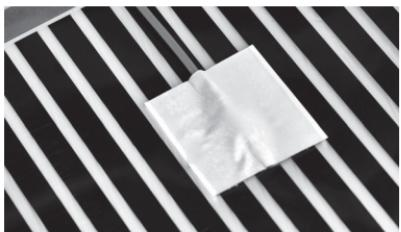
Рис. 17. Установленный и приклеенный датчик температуры пола.
