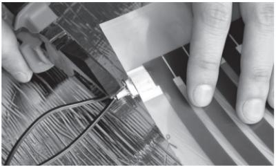
Рис. 12. Надежно зажмите провода в контактном зажиме
