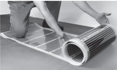
Рис. 3. Раскатывание рулона теплого пола на теплоотражающем материале
