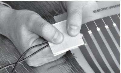
Рис. 14. Установка верхнего листа изоляции
