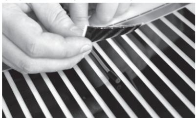
Рис. 16. Датчик прикрепляется к термопленке битумной изоляцией
