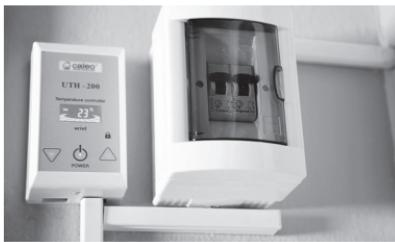
Рис. 20. Терморегулятор, подключенный к сети через отдельный автомат
