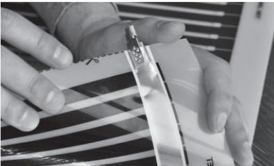
Рис. 5. Установленный на термопленку контактный зажим
