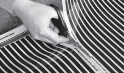
Рис. 4. Разрезание термопленки по линиям отреза
