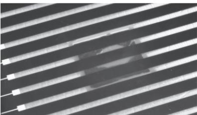
Рис. 19. Установленный и приклейенный датчик температуры пола.
